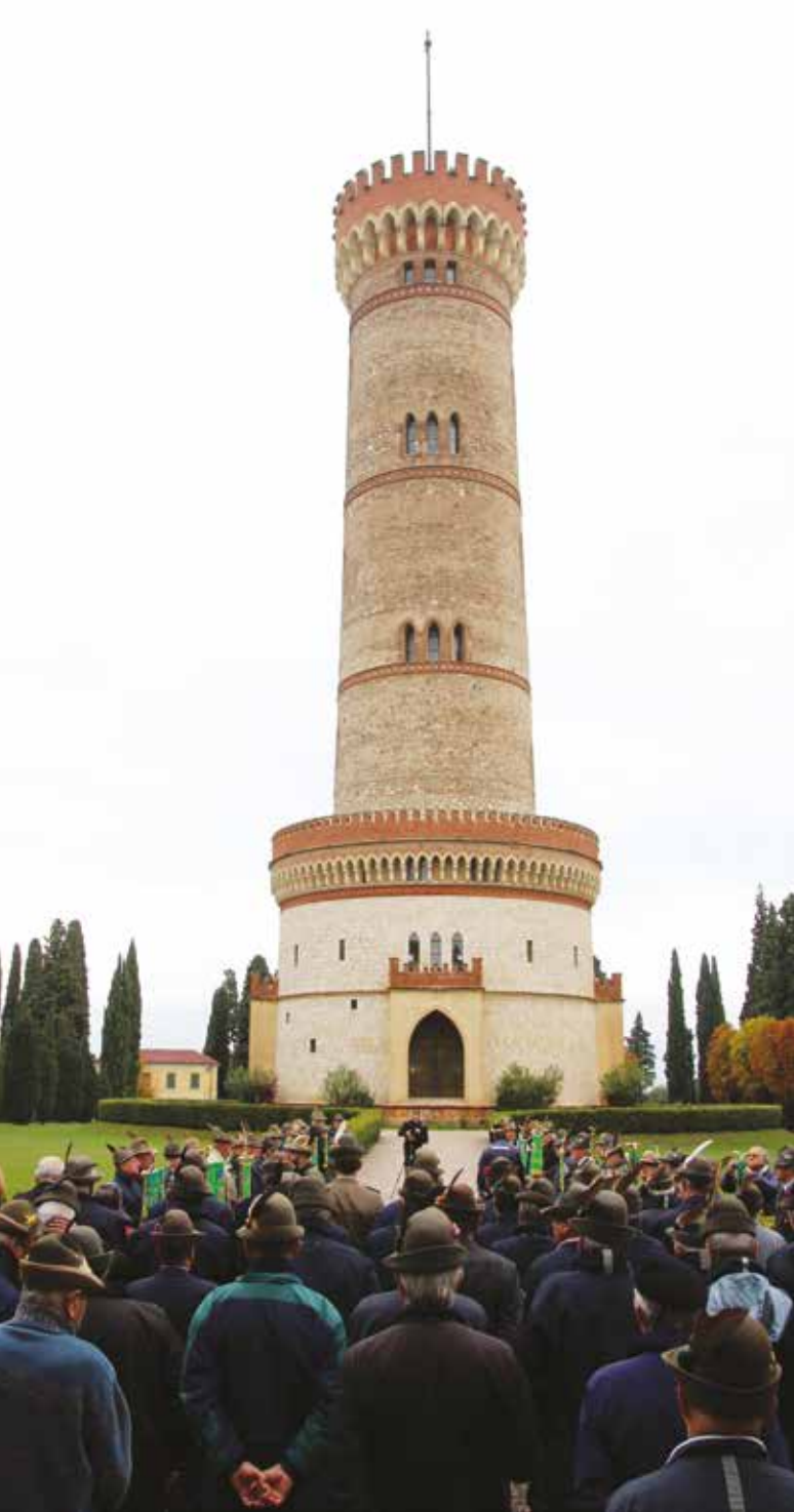
A sinistra, San Martino della Battaglia, frazione di Desenzano del Garda (BS); nelle foto sotto e nella pagina accanto, Salsomaggiore Terme (PR) nel 2017.
